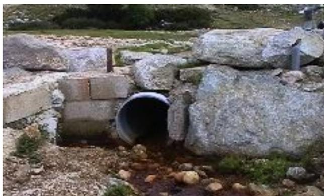
Figure n°=35 : passage busé à la station de Val d'Ese
